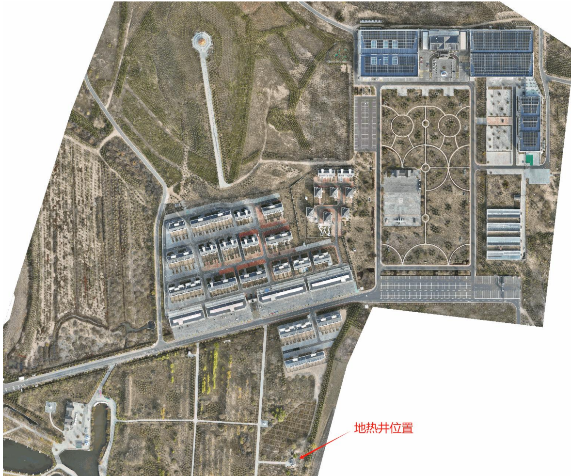
图 1-2 地热井及周边现状
